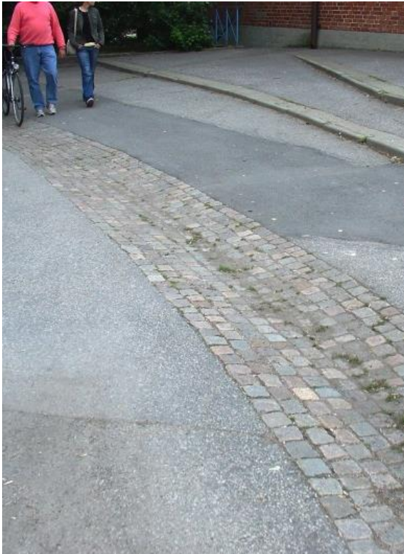
Figur 4: Afledning af vand i midten af vejprofilen, Arnhem, Holland
