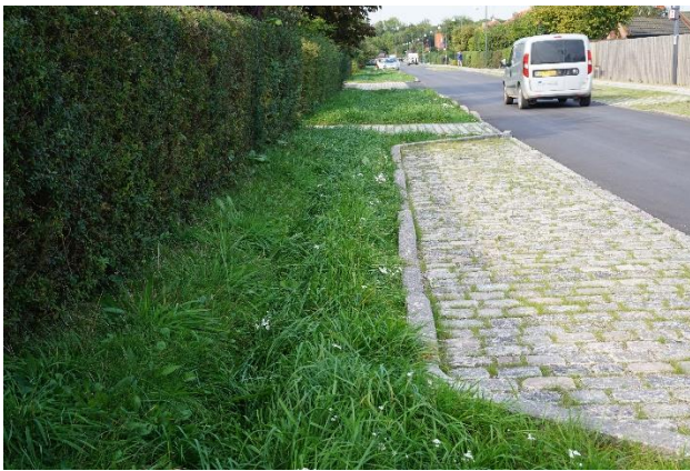
Figur 12: Regnbede og grøft på Lørenskogvej, Rødovre
