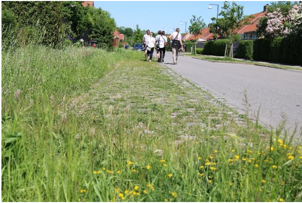
Figur 11: Regnbede og grøft på Lørenskogvej, Rødovre
