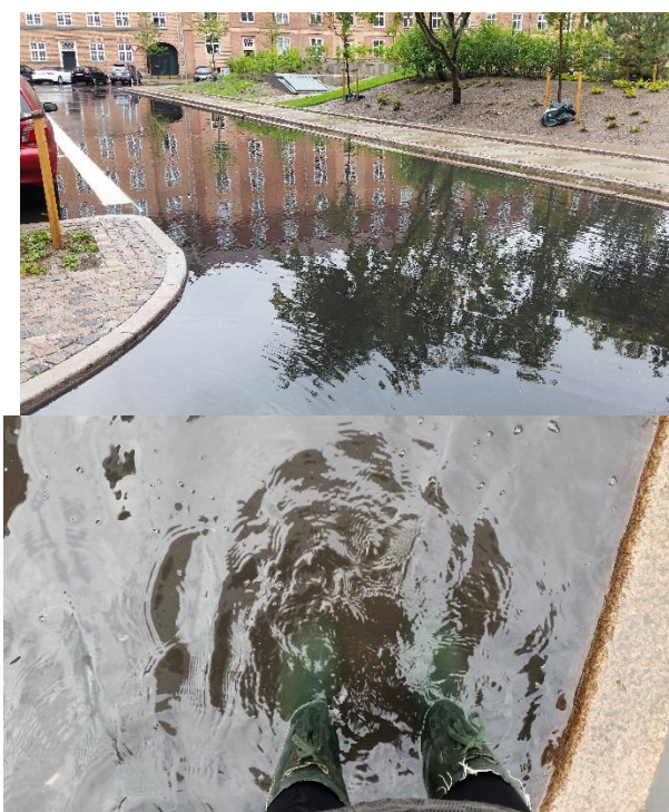
Figur 9: Billeder af hævede kantsten omkring Tåsinge Plads i skybrud juni 2015
