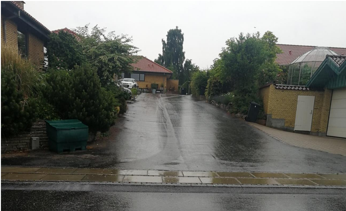
Figur 3: Afledning af vand i midten af vejprofilet, Pigekvarteret, Middelfart
